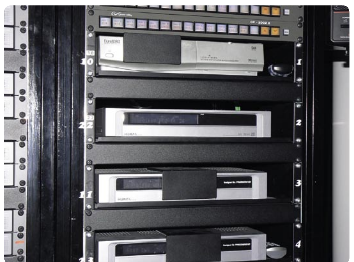
▲ Kvaliteta emitiranog signala provjerava se standardnim HDTV prijemnicima, poput ovih tvrtke Humax.
