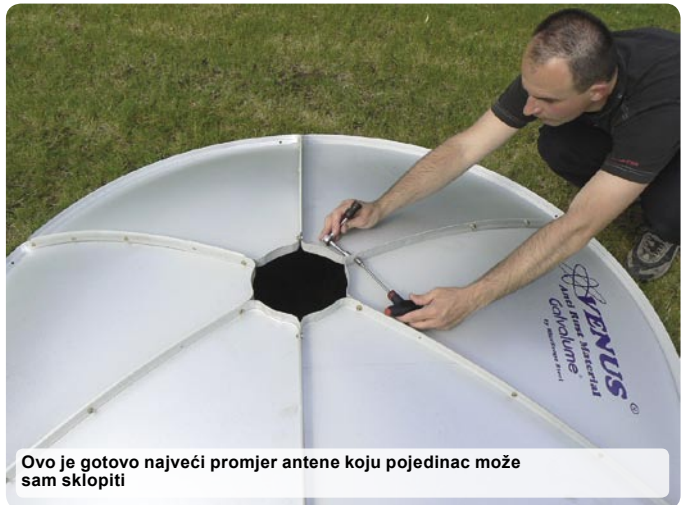
Bočni su zidovi segmenata iskrivljeni na jednu stranu kako bi se povećala stabilnost
